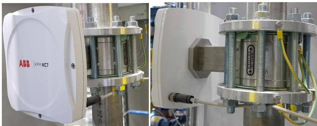
Fig. 4.2. Instalação do tipo wafer/sanduíche do sensor de vazão KC7.
